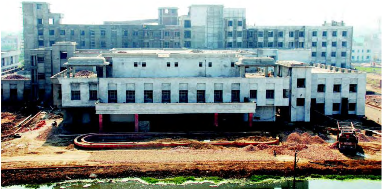
निर्माणाधीन ट्रॉमा सेन्टर
