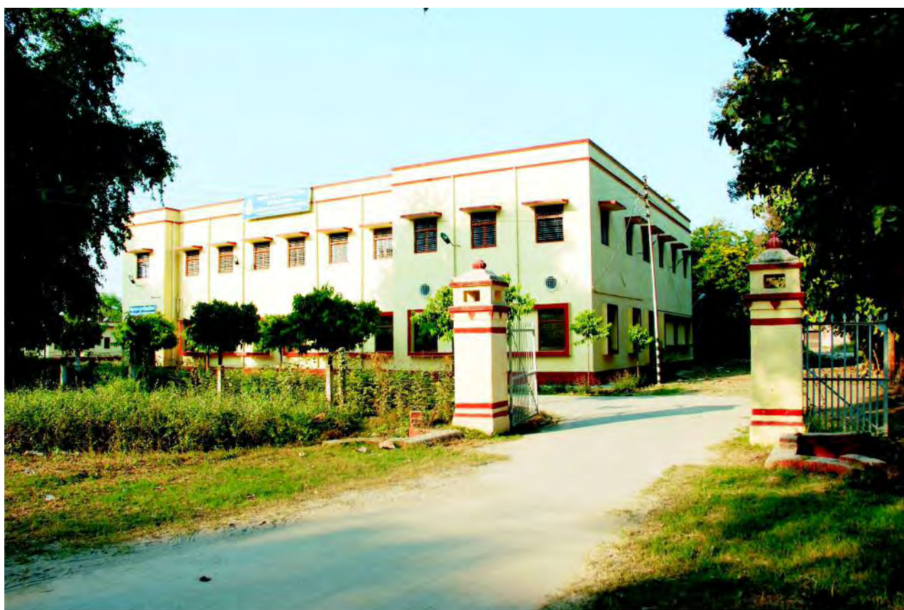
पशुपालन एवं डेयरी विभाग के प्रथम तल का निर्माण
