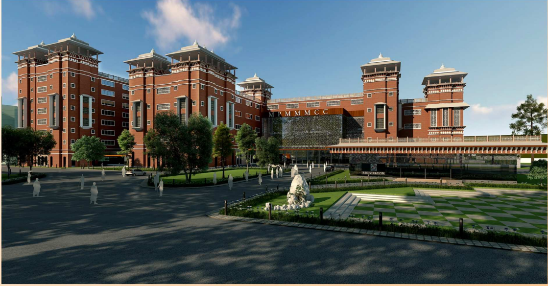
निर्माणाधीन पं० मदन मोहन मालवीय कैंसर सेन्टर Upcoming Mahamana Pt. Madan Mohan Malaviya Cancer Centre
